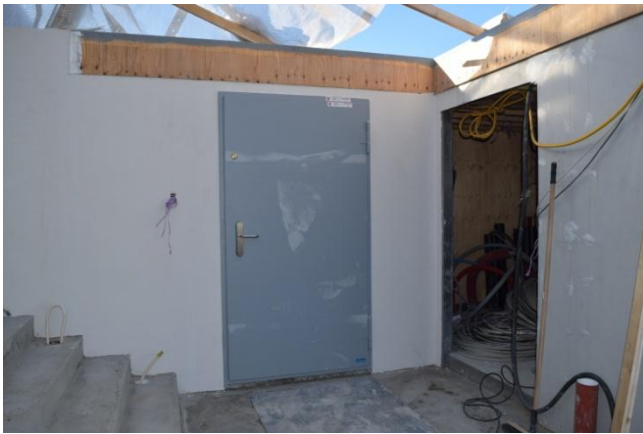
Buchele højvandssikker dør foran kældernedgang.
