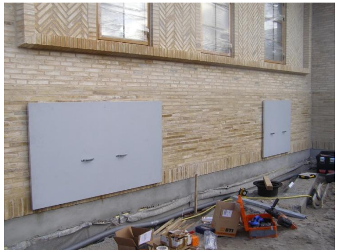
WHS magnetskot i special design tilpasset kundeønske.
