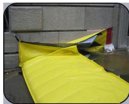
Water Gate lagt op af en væg
