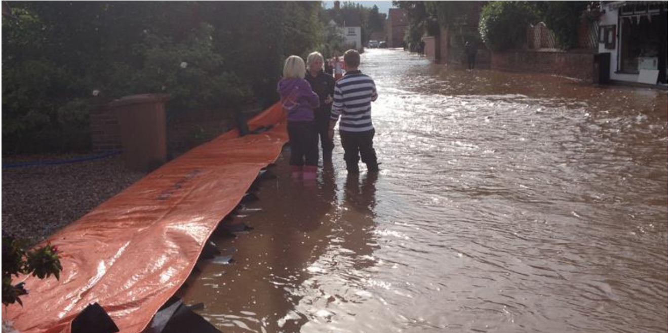
Billederne stammer fra oversvømmelserne i England i 2012, med Water Gate™ i funktion.
